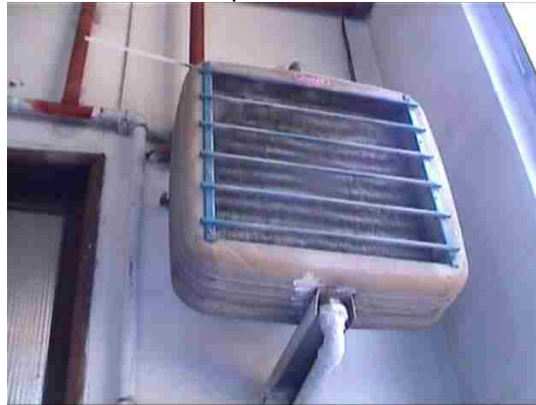
Un esempio di pannello radiante installato in un asilo nido
