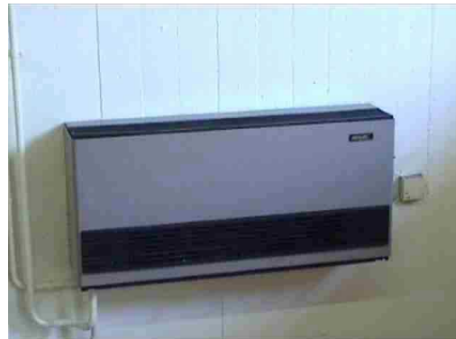
Un esempio di ventilconvettore
